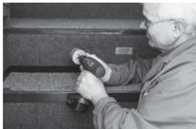
**Schritt 2:** Mit einer Tassenfräse (60 mm) befestigen Sie nun die Saugdose an der 3. Stufe.
