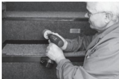
**Fase 2:** Con una fresa a tazza (60 mm), fissare la presa aspirante al 3° gradino.
