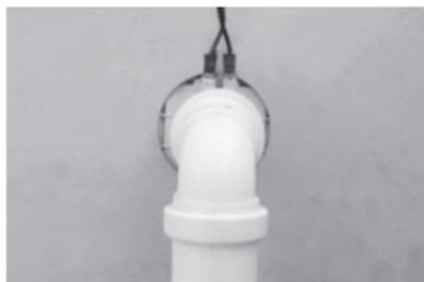
**Schritt 4:** Befestigen Sie die blaue und braune Litze an den Schrauben der Saugdose.
