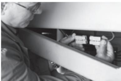
**Fase 5:** Collegare uno dei cavi di 6 mm<sup>2</sup> ad un fusibile di 40A (assorbimento 23A), collegare il secondo cavo alla massa. Se si desidera una lunghezza maggiore, utilizzare un cavo di 10 mm<sup>2</sup>.
